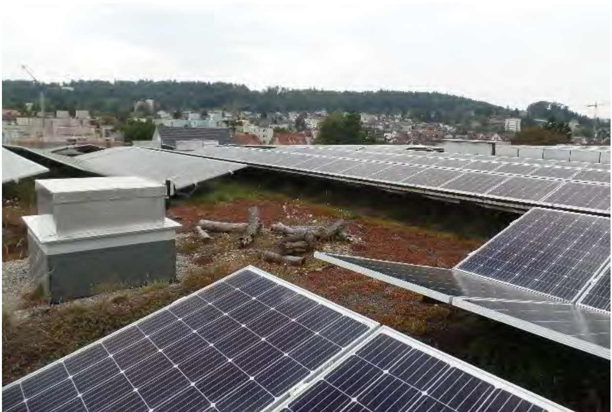
Kombination extensives Gründach, PV und Totholz/ Foto Bodensee-Stiftung
