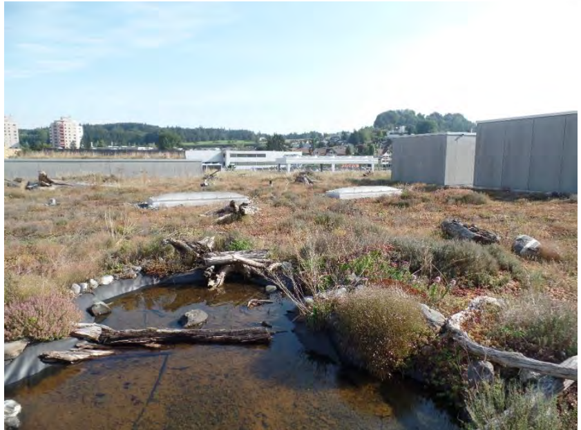
Biodiversitätsförderndes Gründach Migros, Ostschweiz/ Fotos: Bodensee-Stiftung
