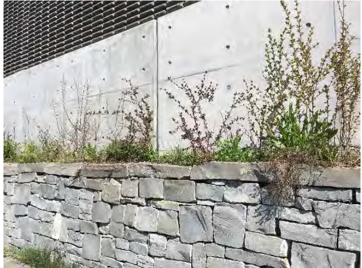
Trockenmauer Bahnhof Rankweil/ Foto: Bodensee-Stiftung
