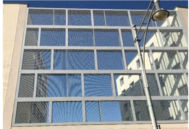
Vogelsichere Lärmschutzwand/ Foto: Bodensee-Stiftung
