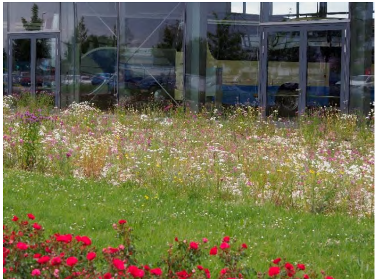
Feuerwehrumfahrung/ Foto Bodensee-Stiftung
